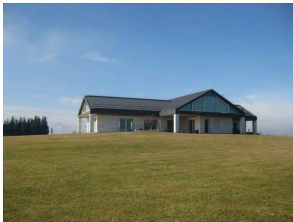
Figura 4.6/2 Area 2 PROD – Vista dell'edificio 1
