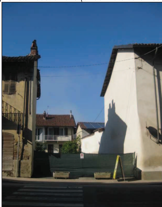
Figura 4.2/5 Vista dell'area 2 RES – Stato attuale
