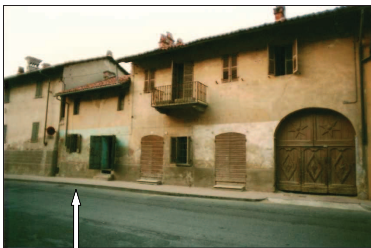
Figura 4.2/3 Vista dell'area 2 RES prima della demolizione del fabbricato di prevista ricostruzione (evidenziato dalla freccia)
