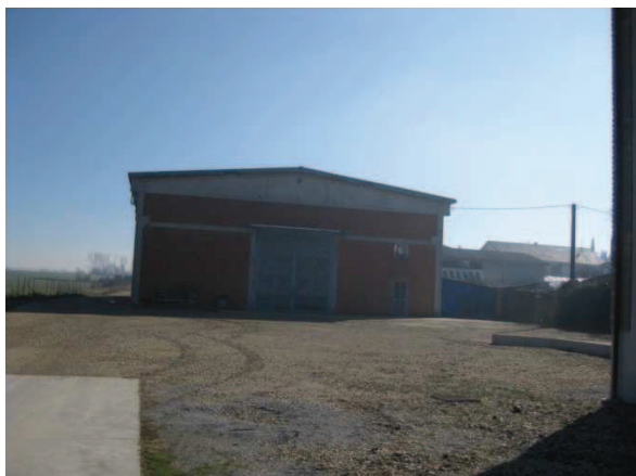
Figura 4.5/2 Vista dell'area 1 PROD – Fronte lato ingresso
